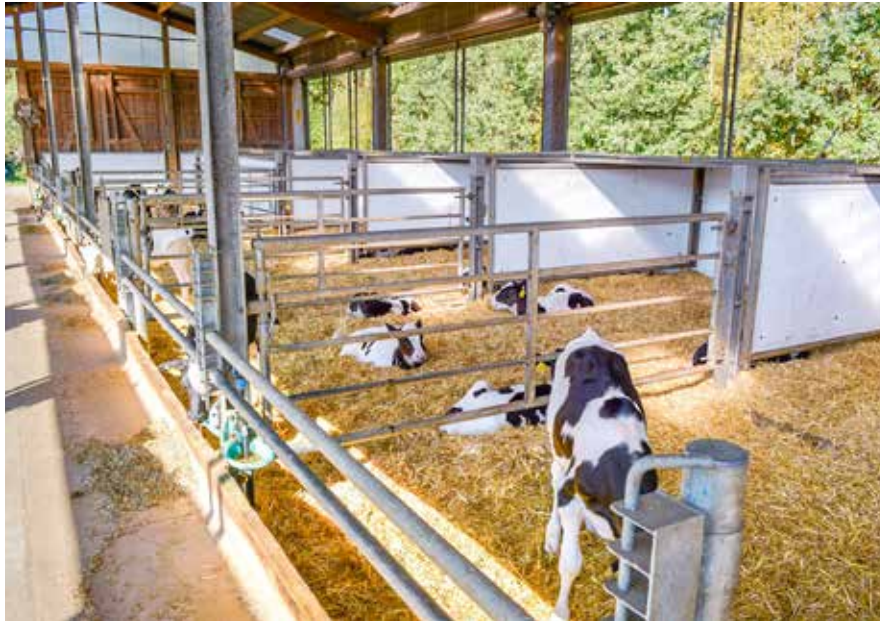
Ideale Stallklimabedingungen im Sommer. In der nasskalten Jahreszeit können, wenn die Jalousien stärker verschlossen werden, auch hier Probleme auftreten. Wichtig ist es dann, Zuglufterscheinungen zu verhindern. Fotos: Dr. Hans-Jürgen Kunz
