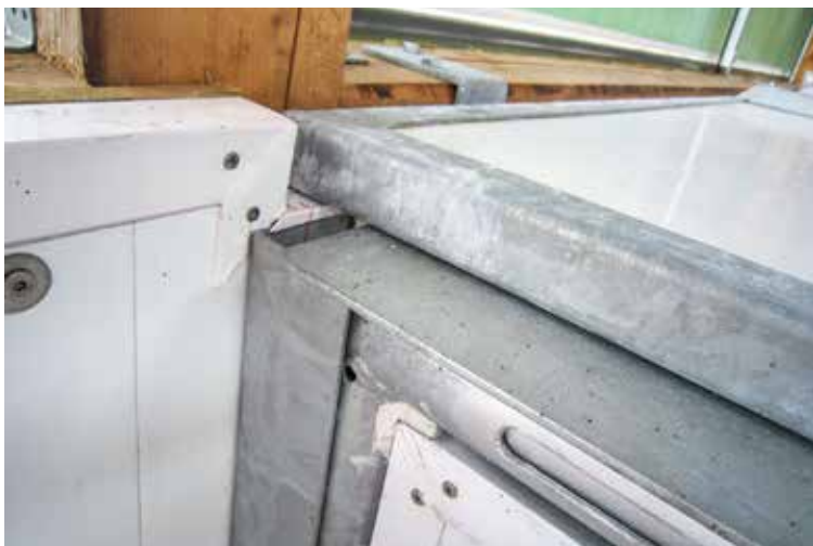
Ein Kälbernest muss im geschlossenen Zustand dicht abschließen, siehe linkes Foto. Hier kommt es auf die Bauweise an, gut erkennbar bei geöffnetem Deckel auf dem rechten Foto. Dieses Kälbernest verhindert im geschlossenen Zustand das Eindringen von Zugluft.
