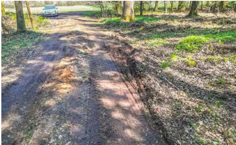
Dieser Weg ist schon stark befahren worden und sollte saniert werden.
