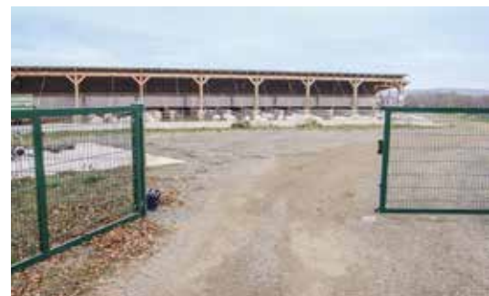
Das gesamte Betriebsgelände hat Fritz Hold mit einem stabilen Zaun mit Unterwüchlschutz umgeben.
