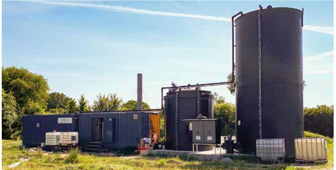
Unscheinbar versteckt sich ein Teil der Aufbereitungsanlage in den blauen Containern. Daneben befinden sich ein Tank mit Schwefelsäure (klein) und der Tank für die gewonnene ASL-Lösung (groß). Fotos: Anna-Lena Baumgardt
