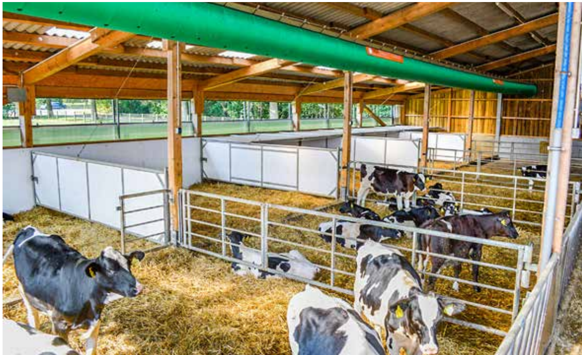
Mit einer temperaturgesteuerten Schlauchlüftung kann der Keimgehalt in der Stallluft deutlich reduziert werden.
