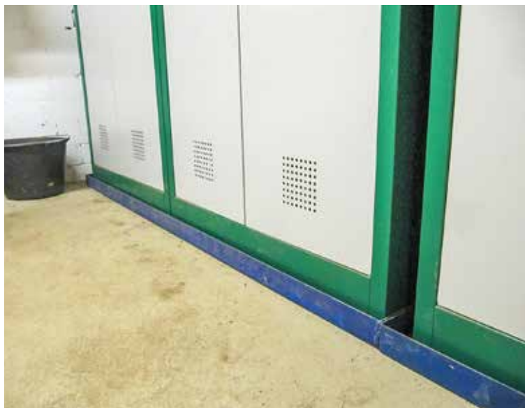
Pflanzenschutzmittelschrank: Hier schützen eine innere und eine äußere Wanne bei Leckagen. Die Schränke sind als Pflanzenschutzmittellager gekennzeichnet, abschließbar und mit einer Absaugvorrichtung versehen, die vor Pflanzenschutzmitteldämpfen schützt.
