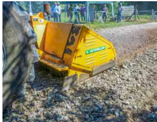
Sanierung 2015: Der Steinbrecher zerkleinert und durchmischt vorhandenes Wegematerial und Feldsteine zur neuen, kornabgestuften Sieblinie für die Tragdeckschicht. Fotos: Hans-Jochim Rohweder
