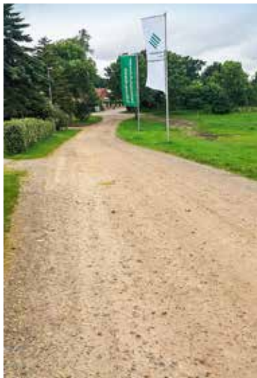
Der sanierte wassergebundene Wirtschaftsweg am Lehr- und Versuchszentrum Futterkamp präsentiert sich nach zwei Jahren Pkw- und landwirtschaftlichem Schwerverkehr noch in einem ausgesprochen guten Zustand.
