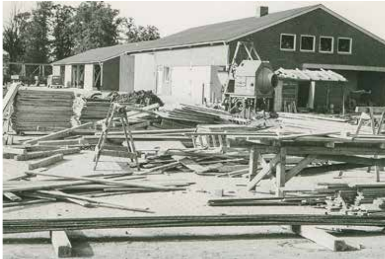
1966 war Futterkamp eine Großbaustelle. Maschinenhalle und Werkstatt waren bereits fertiggestellt, während noch genügend Material bereitlag, um in anderen Gebäuden verbaut zu werden.
