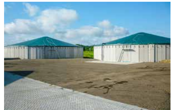
Abdeckungen von Behältern reduzieren die Ammoniakemissionen. Dabei haben Zeltedächer auch den Vorteil, dass Regenwasser keine weitere Verdünnung der Gülle verursacht. Fotos (2): Dr. Eckhard Boll
