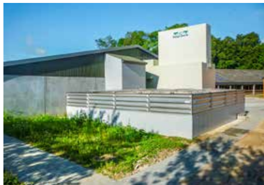
Nährstoffeffizienz beginnt im Stall mit der Fütterung und schließt Abluftfilteranlagen ein, die in größeren Schweine haltenden Betrieben zur Pflicht geworden sind.
