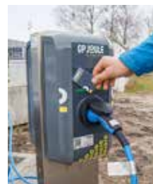
Mit einer Karte oder per App kann der Ladevorgang gestartet werden.
