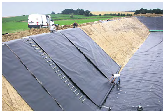
Bild 3: Hier werden die Folienbahnen für ein Gülleerdbecken verlegt.
