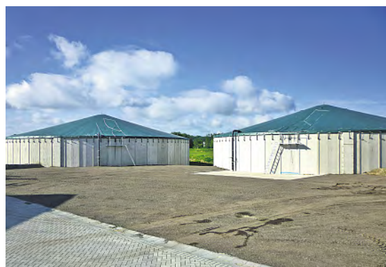
Bild 1: Hochbehälter aus Betonfertigteilen mit emissionsminderndem Zeltdach.
