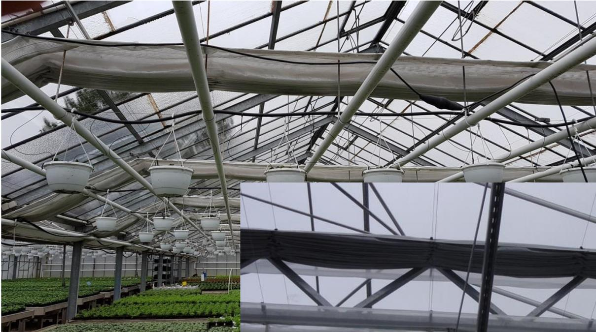
Probleme z.B. bei alten Breitschiffhäusern mit trapezförmigem Energieschirm und hoher Rohrheizung
