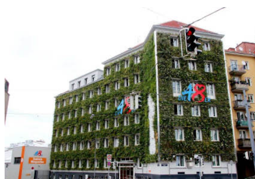
Fassadenbegrünung in der Grünbergstraße in Wien
