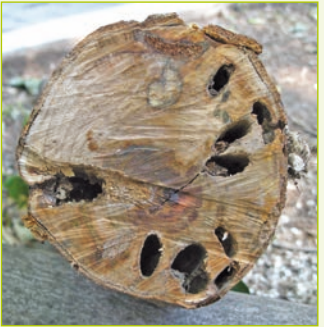
12. Larvengänge im Holzkörper mit beginnender Holzfäule durch sekundären Pilzbefall
