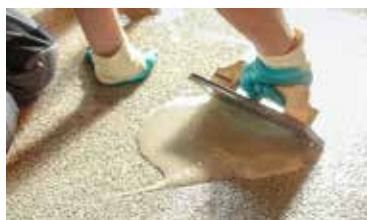
Bodensanierung im Melkstand für eine trittsichere Lauffläche
