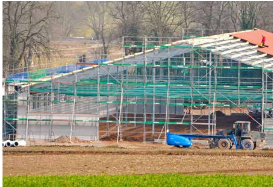
Beim Neubau von Wirtschaftsgebäuden werden die Herstellungskosten steuerlich nur über Abschreibungen berücksichtigt.
