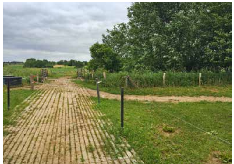
Treibewege wurden durch alte Spaltenbodenelemente für Schweine angelegt. Fotos: Dr. Luise Prokop
