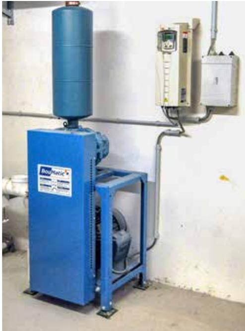
Frequenzgeregelter Vakuumpumpen passen die Leistung dem Bedarf an.
