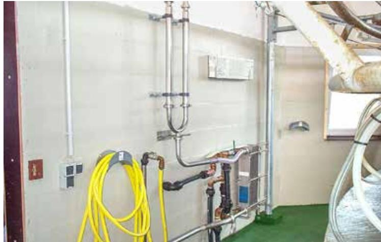
Die beste Möglichkeit, bei der Milchgewinnung Energie zu sparen, bieten Vorkühler (hier Plattenkühler).
