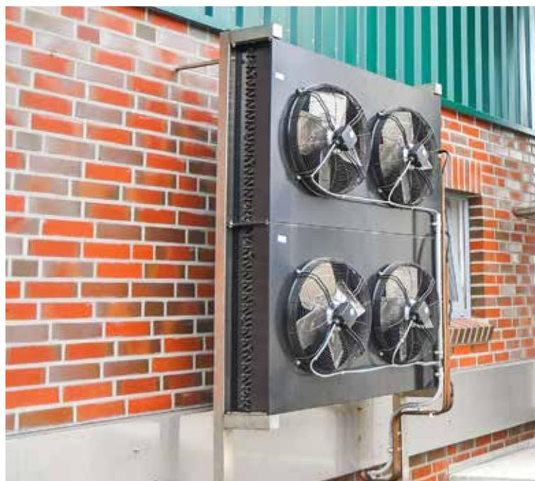
Durch die Anbringung des Kondensators der Kühlung außen am Gebäude findet ein optimaler Luftaustausch statt.
