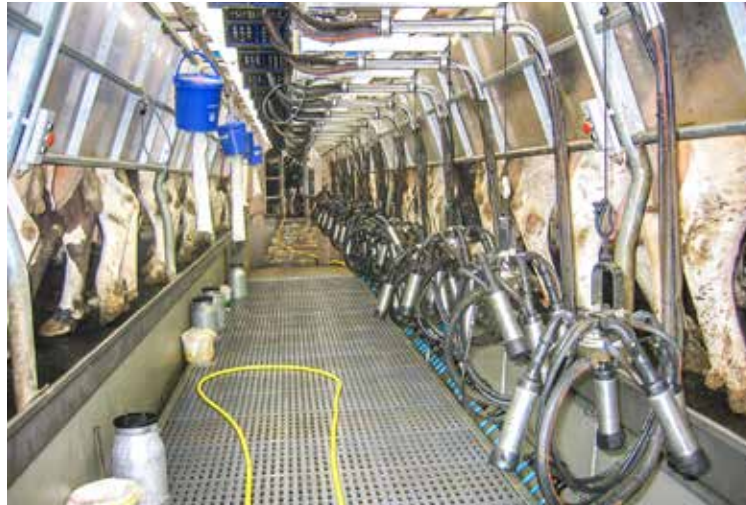
Swing-over-Systeme werden zunehmend in Nordwestdeutschland eingebaut.
