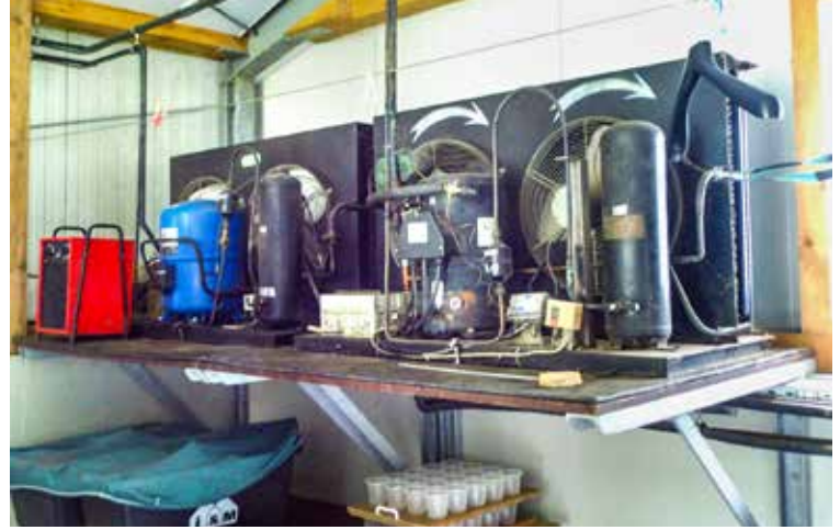
Kühlaggregate sollten immer in Außenluft arbeiten, ein Vorkühler spart zirka 50 % der Kühlenergie.
