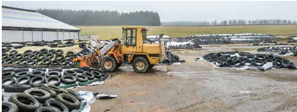
Auf dieser großen Hofplatzfläche müssen alle Oberflächenwässer aufgefangen werden.
