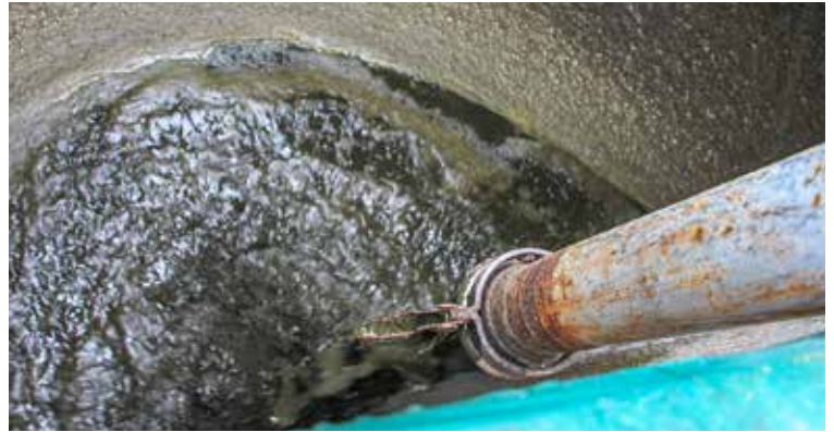
Flüssige Phase, die zurück in den Gülletank geleitet wird
