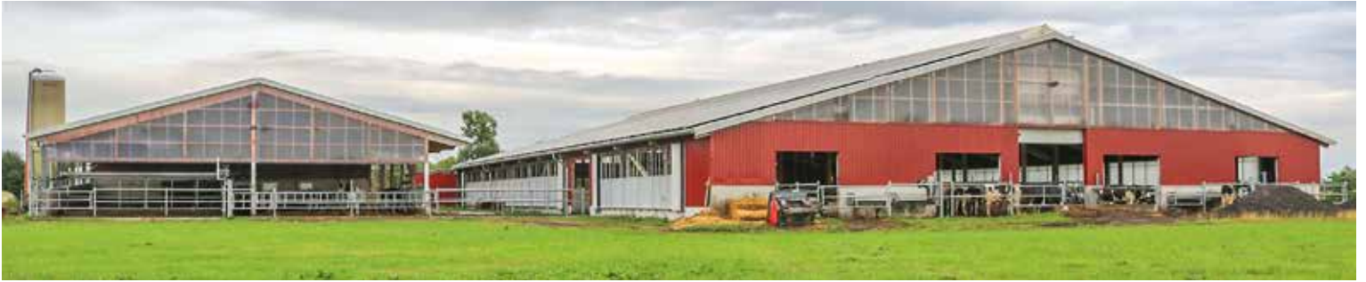
Der neue Stall und das Melkzentrum der Auenmilch GbR
