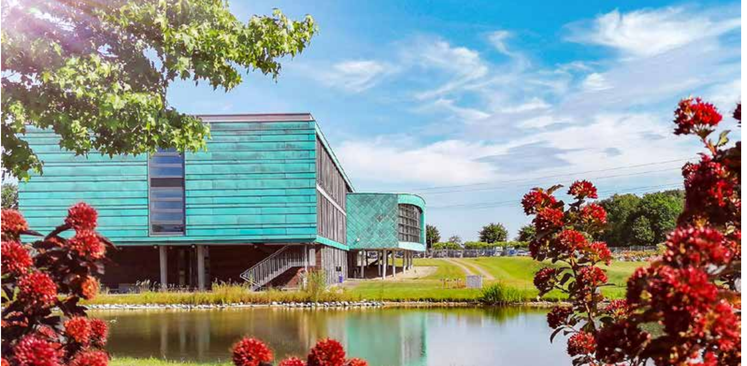
Sieht aus wie ein Blick in die Zukunft, ist aber heute schon Realität: das Gartenbauzentrum der Landwirtschaftskammer Schleswig-Holstein.
