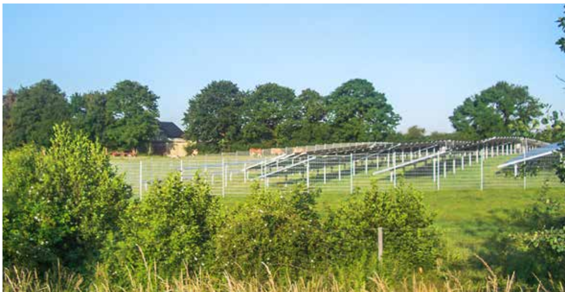
Photovoltaik an einer Autobahn
