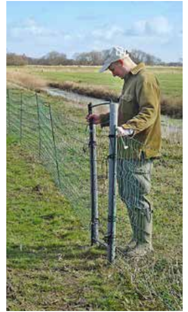
Der Zaunbau ist nur eine von vielen Schutzmaßnahmen für die Bruterfolge der bedrohten Wiesenvögel.
