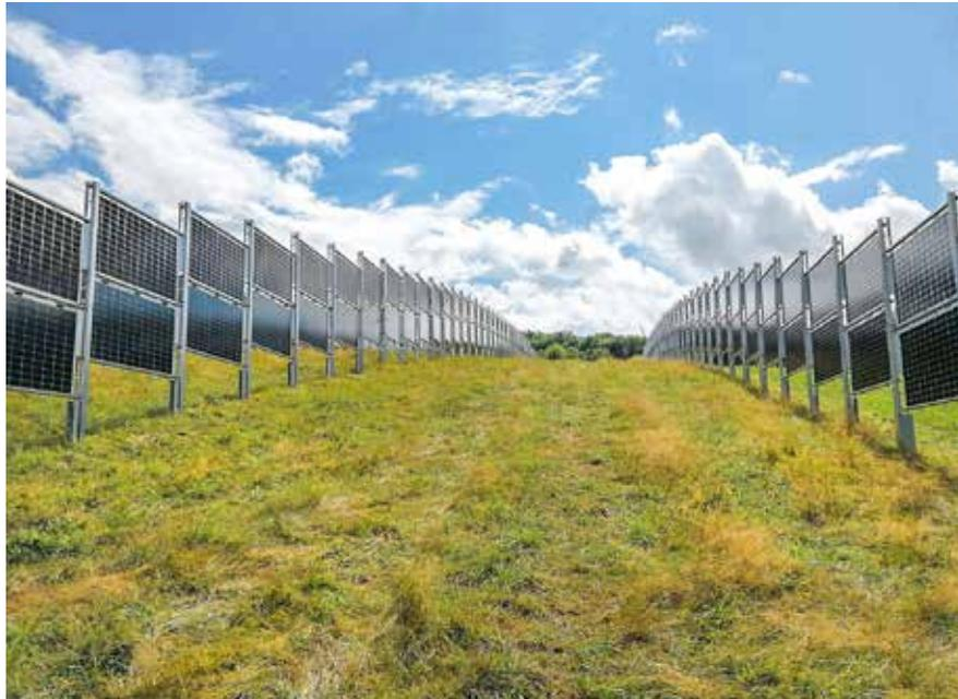
Die ersten Projekte der Agrophotovoltaiknutzung mit vertikal aufgestellten, bifacialen Solarzellen sind umgesetzt. Foto: Werksbild
