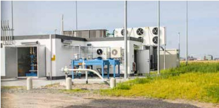
In dieser technischen Anlage wird die Windenergie von der anderen Seite des Nord-Ostsee-Kanals in Wasserstoff umgewandelt. Dadurch kann die Energie gespeichert werden. Foto: Nele Daumann
