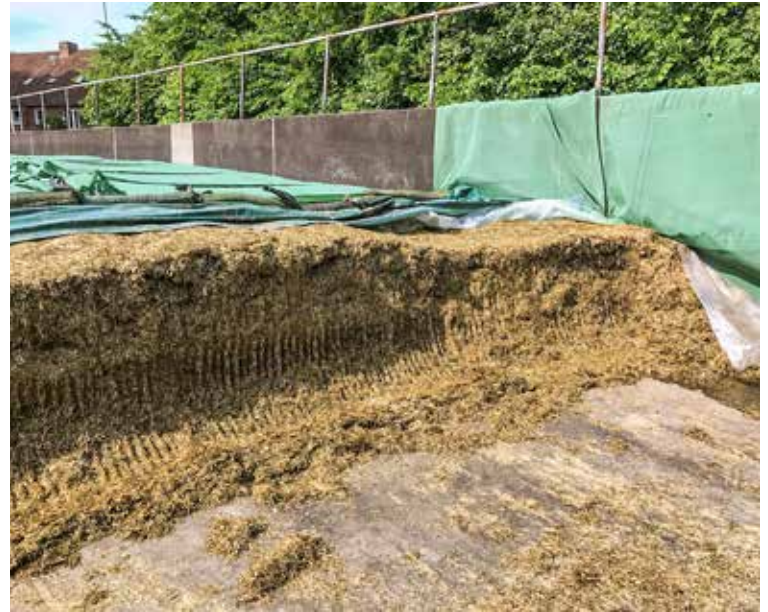
Das Erntegut wurde wetterbedingt nicht ausreichend angewelkt. Über den austretenden Sickersaft gehen wertvolle Inhaltsstoffe verloren.
