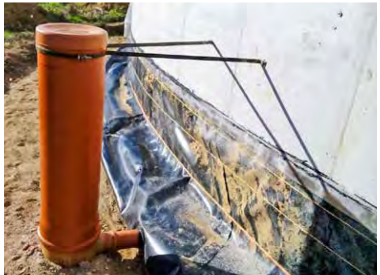
Leckage-Erkennung: vor Anfüllung mit Erde die Folie eng an den Behälter anschmiegen
