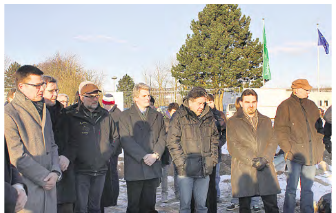
Zahlreiche Gäste aus Politik und Wirtschaft ließen es sich trotz klirrender Kälte nicht nehmen, bei der Grundsteinlegung des neuen Schulbaus dabei zu sein.
