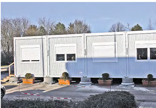
Wegen des großen Schülerandrangs findet der Unterricht in Osterrönfeld teils auch in eigens errichteten Behelfscontainern statt, bis der Neubau steht.
