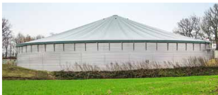
Behälterabdeckungen mit Zeltedächern verringern die Emissionen und vermeiden Niederschlagseinträge.
