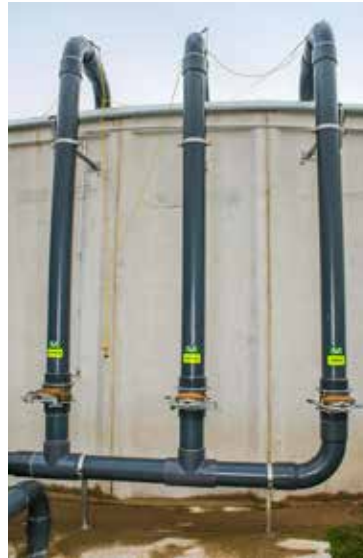
Beim Dickgülleverfahren erfolgt die Entnahme der Dünn- und Dickphase auf unterschiedlichen Höhen im Behälter.
