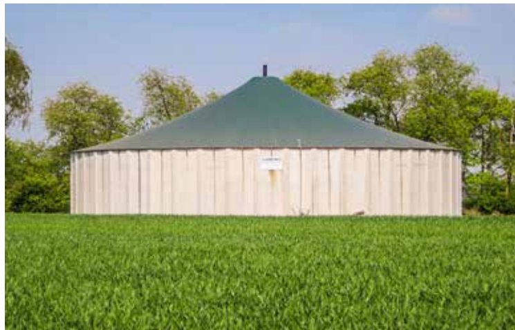
Hochbehälter mit Wandmaterialien aus Beton oder Edelstahl haben sich bewährt. Fotos: Hans-Jürgen Technow
