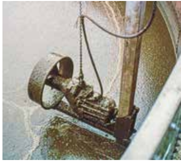
Tauchmotor-Propellerrührwerke werden vorwiegend in Hochbehältern eingesetzt.
